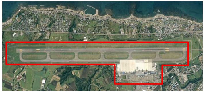
函館空港 排水対策整備箇所
