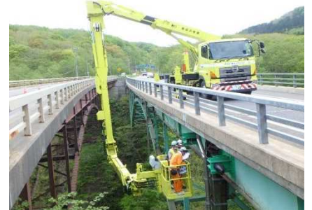
橋梁点検車による橋梁点検状況
