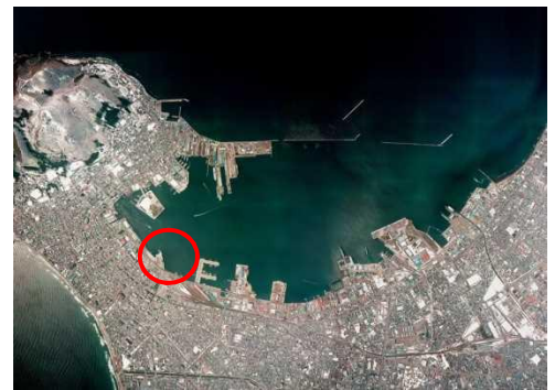
重要港湾函館港若松地区
