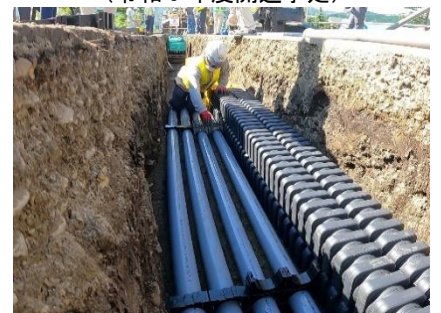
角型多条電線管による低コスト化
