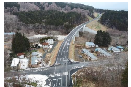
尾札部道路整備状況 （令和5年3月25日延長0.5km部分開通）
