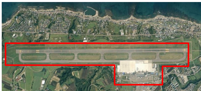
函館空港 排水対策整備箇所
