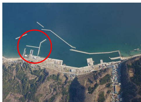
小型船だまりの整備が進む奥尻港
