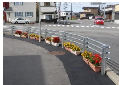
防護柵による安全な通行の確保
