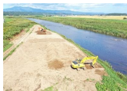
河道掘削状況
