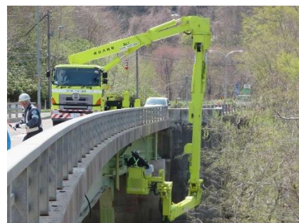
橋梁点検車による橋梁点検
