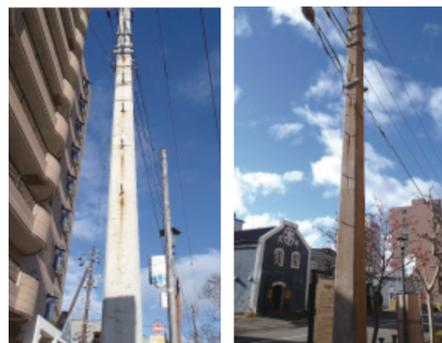
夫婦電柱 (現存する日本最古のコンクリート電柱)
