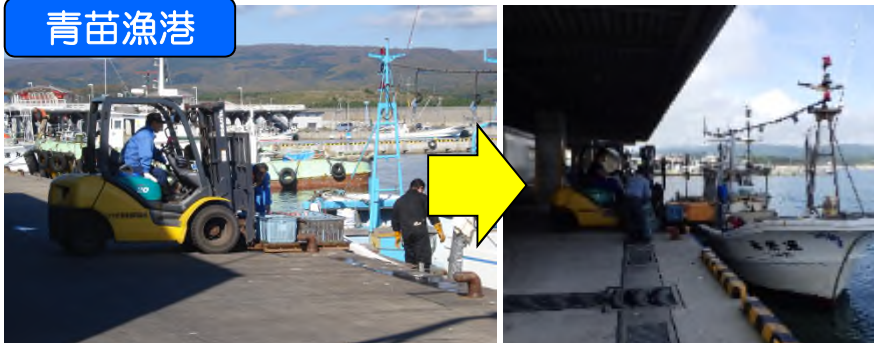
青苗漁港 屋根付き岸壁（-3.5m岸壁） [平成29年度完了]
