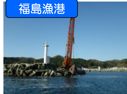
福島漁港 防波堤の整備 [平成28年度完了]
