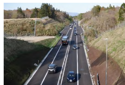
茂辺地木古内道路の整備状況 (R4.3.26開通)
