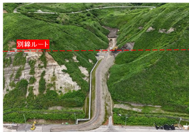
②工事用道路施工中 (令和6年6月25日) 写真(b)
