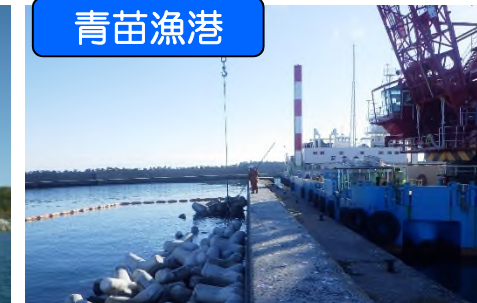
青苗漁港 防波堤の改良 [令和3年度完了]
