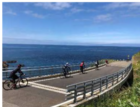
国道228号 上ノ国町小砂子
