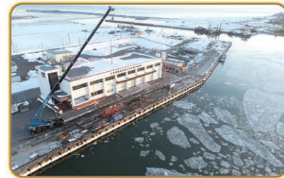
大津地区 係留施設整備状況
