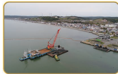
厚岸地区 水域施設整備状況
