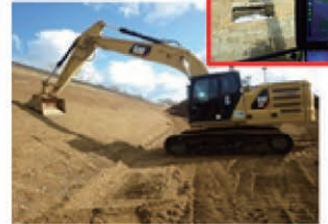
ICT建設機械での切土法面の掘削状況
