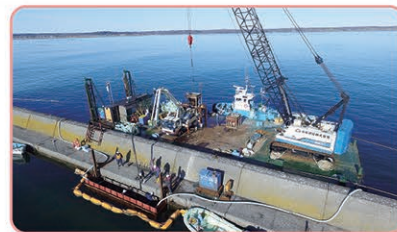
霧多布港本港地区北防波堤整備状況
