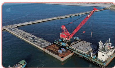
釧路港西港区土砂処分場整備状況
