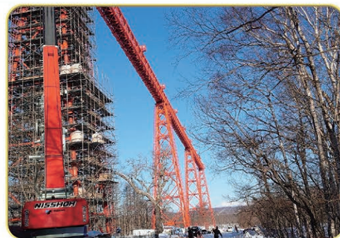
釧路空港進入灯橋梁改良状況
