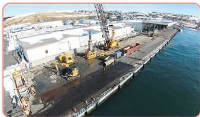
根室港花咲港区水深5.5m岸壁整備状況
