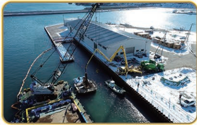
落石地区 係留施設整備状況
