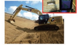
ICT建設機械での切土法面の掘削状況
