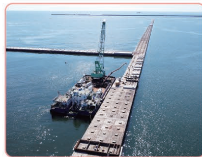
西港区 新西防波堤整備状況
