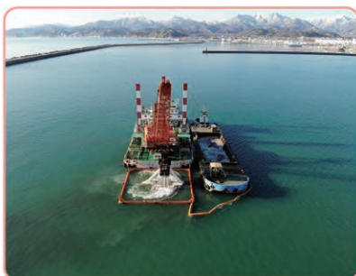
本港地区 航路浚渫状況
