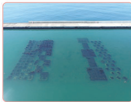
浅場の起伏ブロックによる藻場の生育状況
