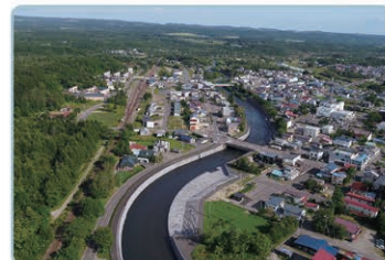
釧路川の河川改修状況
