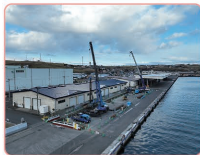
花咲港区 水深6m岸壁整備状況
