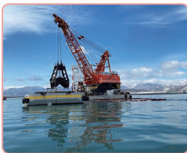
本港地区 航路浚渫状況
