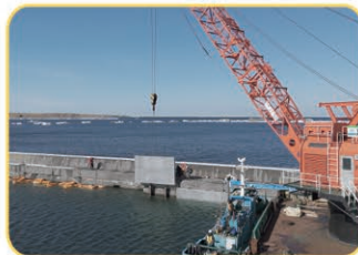
防波堤補修状況
