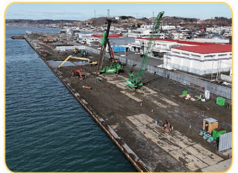
岸壁高上げ整備状況
