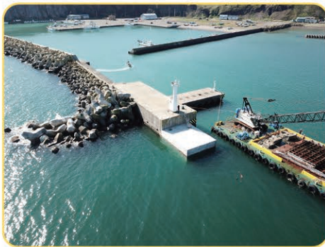
防波堤整備状況
