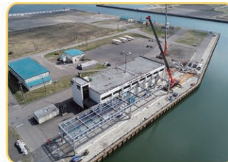
屋根付き岸壁整備状況
