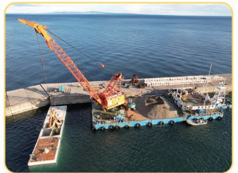
防波堤整備状況
