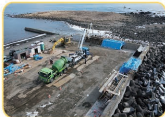
護岸高上げ整備状況
