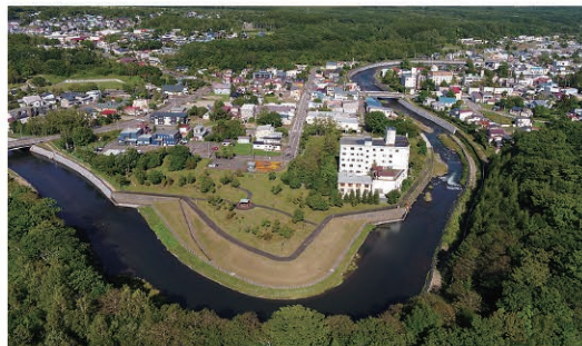
釧路川の河川改修状況
