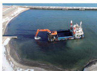
大津地区泊地浚渫状況
