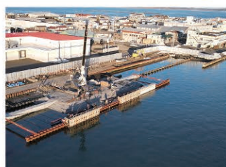
厚岸地区岸壁嵩上げ整備状況
