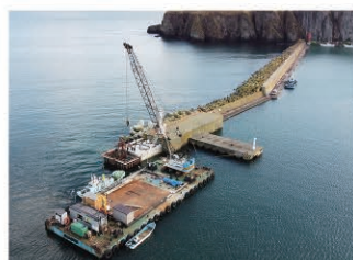
落石地区防波堤整備状況
