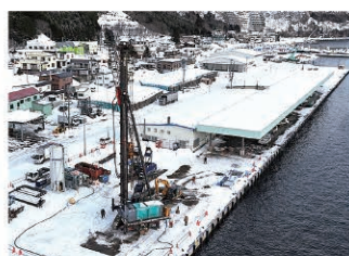
羅臼地区屋根付き岸壁整備状況
