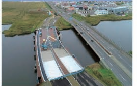
国道44号 雪裡橋架替
