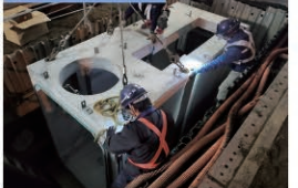
国道38号 釧路橋北地区 電線共同溝
