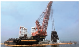
十勝港本港地区 航路浚渫状況
