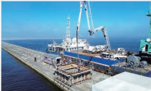
釧路港西港区 新西防波堤 上部コンクリート打設状況
