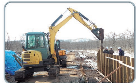
土砂流入対策(湿原流入部土砂調整地)整備状況
