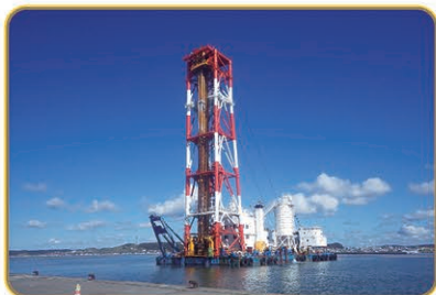
厚岸地区岸壁整備状況
