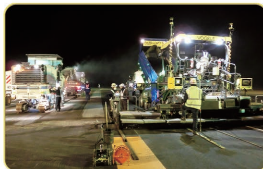
釧路空港滑走路改良状況
