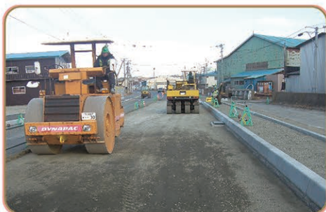
根室港花咲地区道路整備状況
