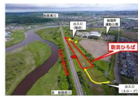
釧路町 緊急広場整備
