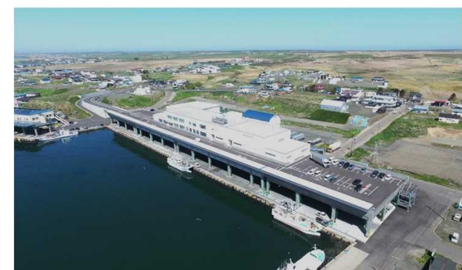
歯舞漁港 屋根付き岸壁・人工地盤
