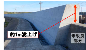
霧多布港 防潮堤改良
