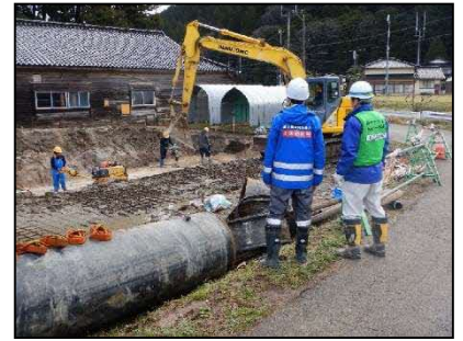
【復旧工事の状況】
