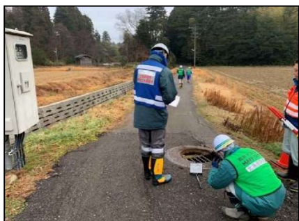
【農業集落排水施設の調査】
