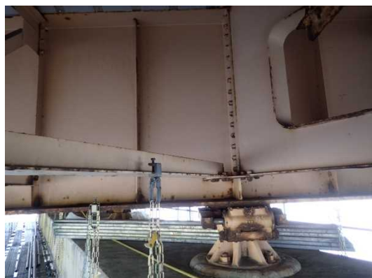
【橋梁補修前（支承）】
