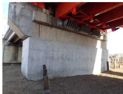
【耐震補強（落橋防止工）】
