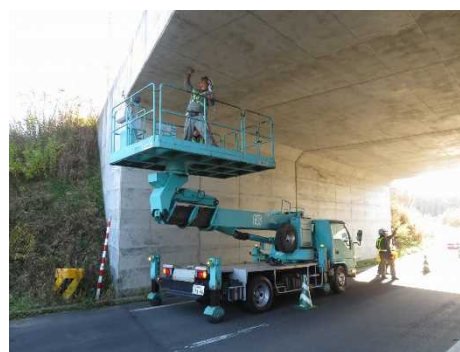
【大型カルバート点検】
