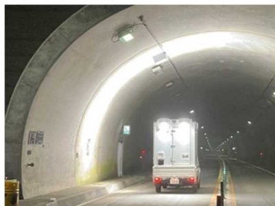
画像計測技術による覆工撮影
