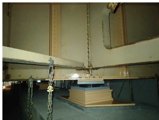
【橋梁補修後（支承）】
