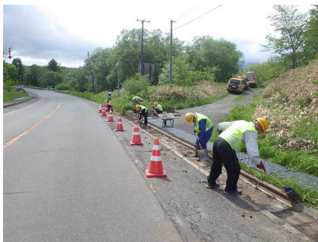
【排水構造物清掃】
