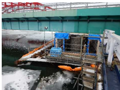
【耐震補強（下部工補強）】
