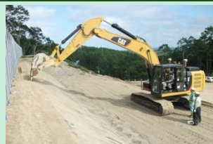
▲ICT施工確認状況
