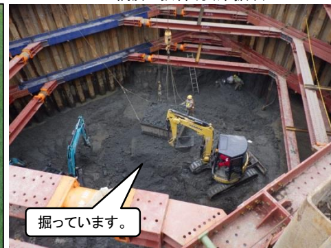
▼P3橋脚 仮締切(床掘り)
