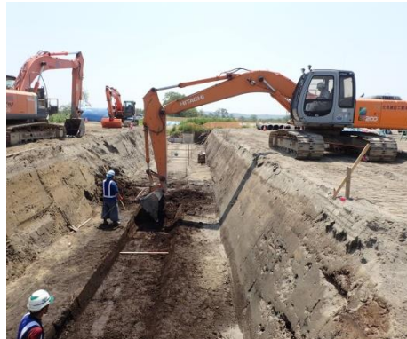
▼横断排水管施工状況
