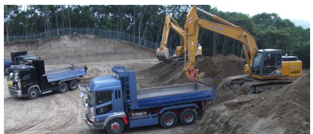
▼切土部(掘削工)
