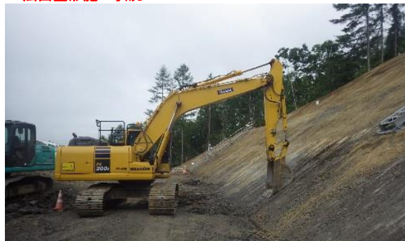
法面整形施工状況
