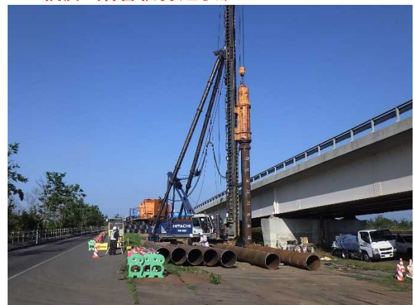
P1橋脚 鋼管杭打込状況
