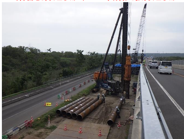
P1鋼管杭打込状況、A1土留鋼矢板打込状況
