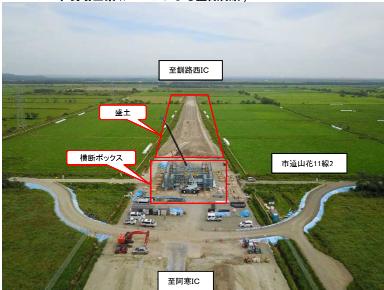
▼盛土完成状況(ドローンによる空撮撮影)
