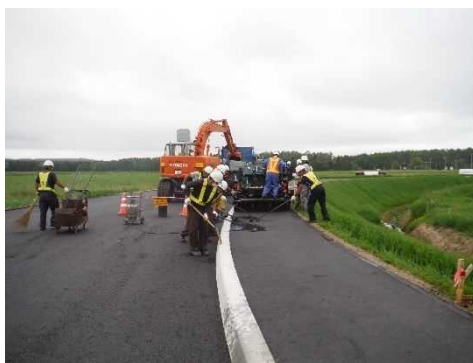
▼迂回路(歩道舗装工)敷均し施工状況
