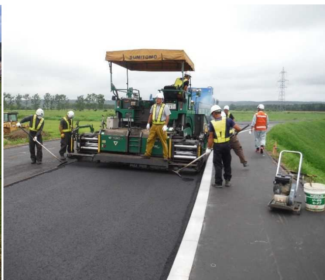
▼迂回路(歩道舗装工)敷均し施工状況
