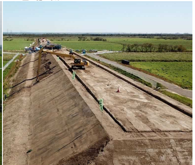
▼道路横断ボックス 枠組足場施工状況
