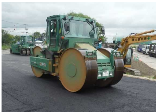
▼迂回路(車道舗装工)転圧施工状況
