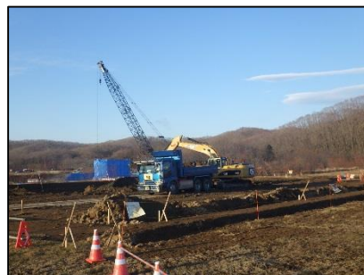
▼P3橋脚 掘削状況
