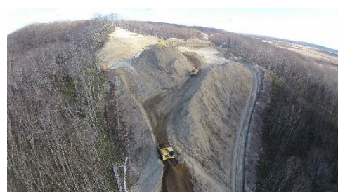
▼切土部(掘削工)
