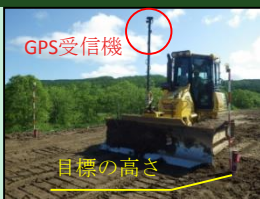
▲マシンコントロールによる土砂敷均作業
