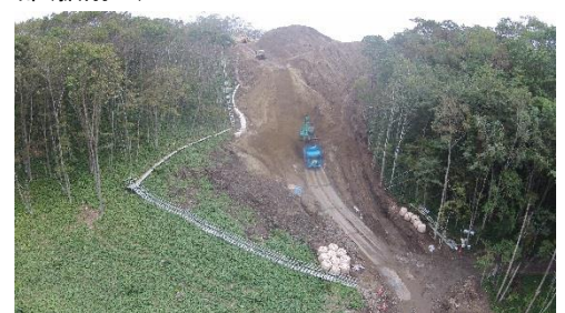
▼切土部(掘削工)
