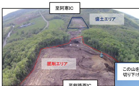
▲工事現場全景
