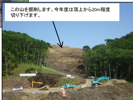
▼切土部(掘削工)
