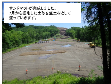
▼盛土部(载荷盛土)
