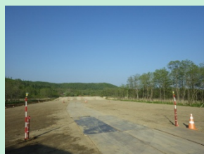
▲沈下板設置状況
