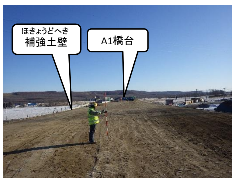
▼A1橋台背面側 補強土壁施工完了
