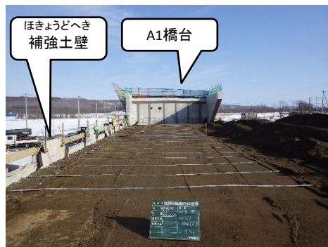
▼A1橋台背面側 補強土壁施工
