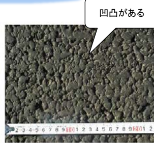
▲SMA舗装表面
