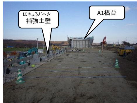
▼A1橋台背面側 補強土壁施工
