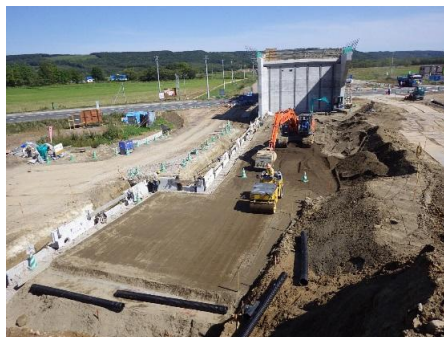
▼A1橋台背面側 補強土壁施工
