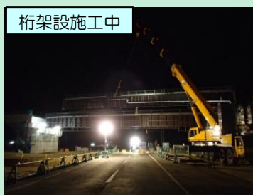
桁架設完了
