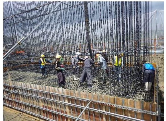
A1橋台工のフォーミング(底版)コンクリート打設作業
