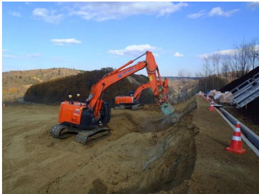
(ICT重機による法面整形状況)
