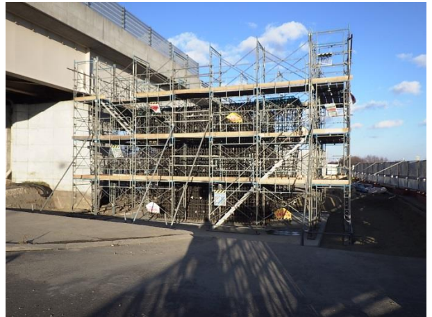
P5 壁式橋脚組立完了
