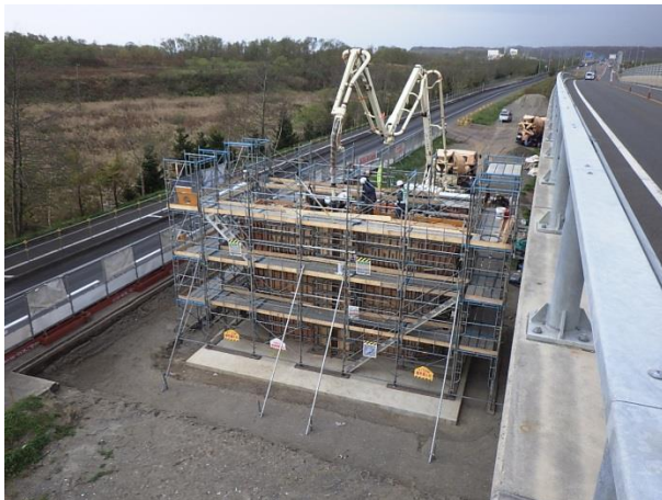
P3 壁式コンクリート散水養生
