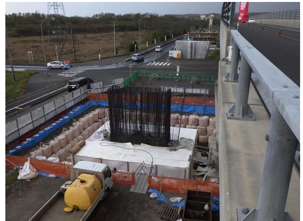
P5 底板コンクリート散水養生
