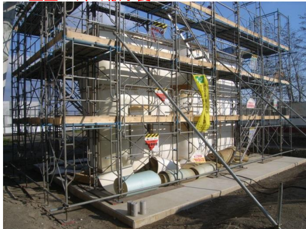
P3 壁式コンクリート散水養生
