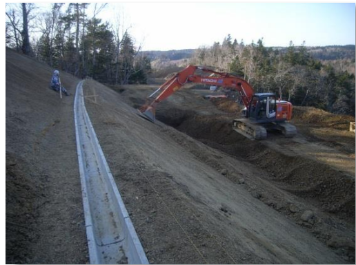
本線 法面工 切土法面整形
