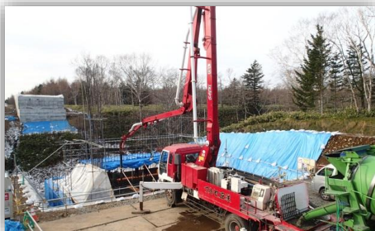
底板コンクリートの防寒養生と湿潤養生
