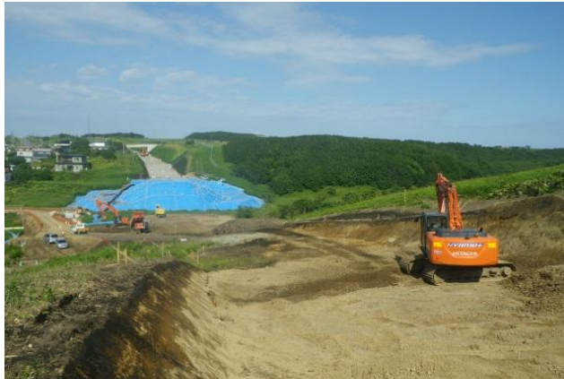
A2載荷盛土施工状況
