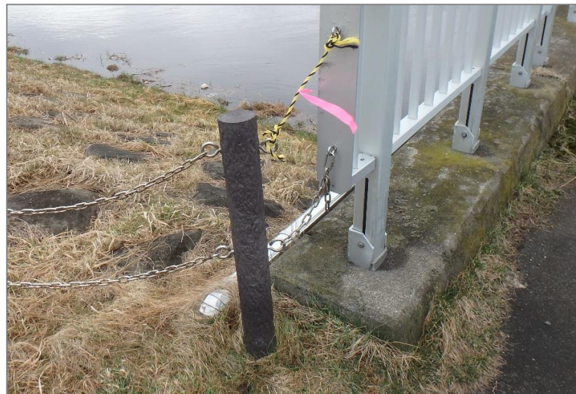
応急処置・注意喚起テープ設置
