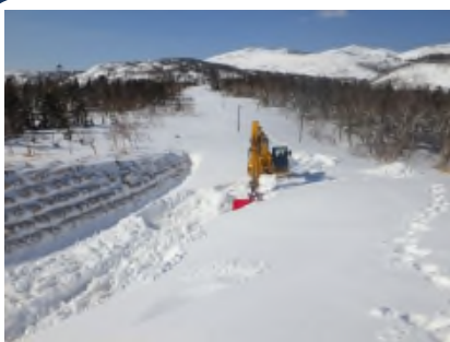
油圧ショベルによる作業状況
