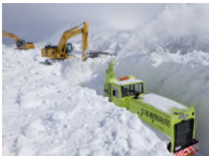
ロータリ除雪車による作業状況
