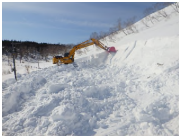
油圧ショベルによる斜面除雪
