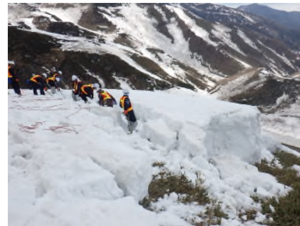
人力による雪庇処理、斜面除雪
