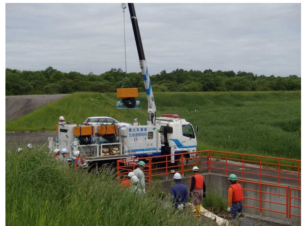
④水中ポンプ投入 (堤内側 呑口状況)
