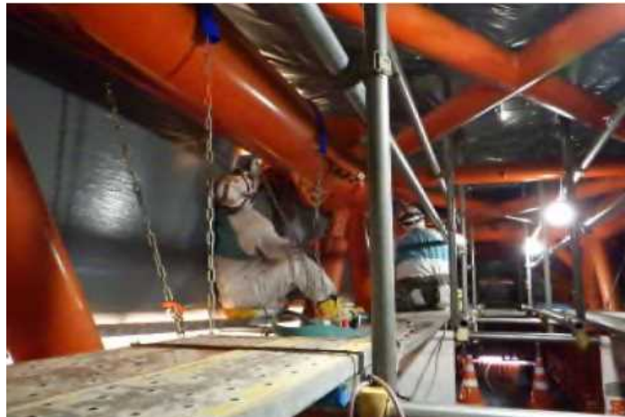
④素地調整作業(ケレン)
