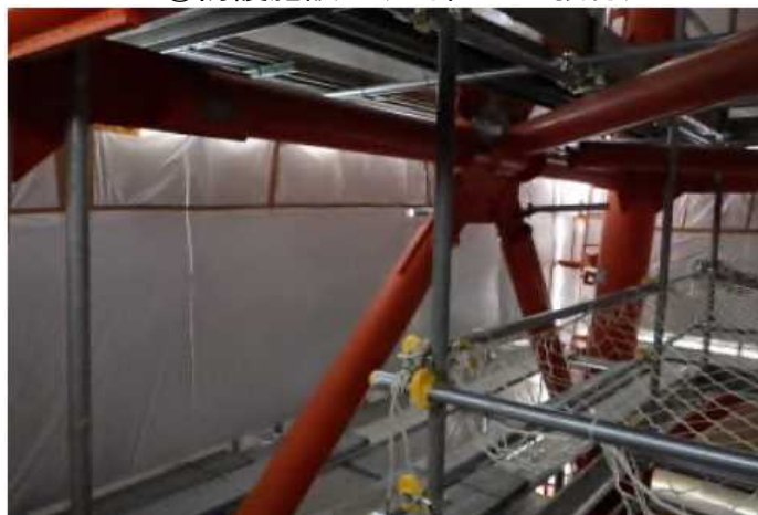
③防護施設工(内部シート張付)
