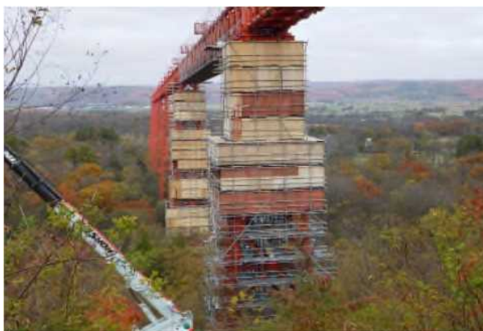
②防護施設工(コンパネ設置)
