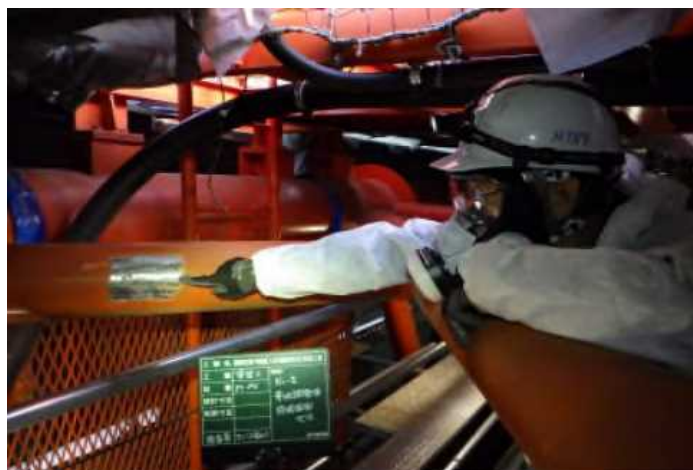
⑤素地調整作業(ケレン)後確認
