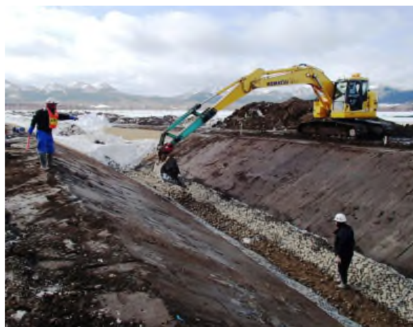
排水路整備工事
