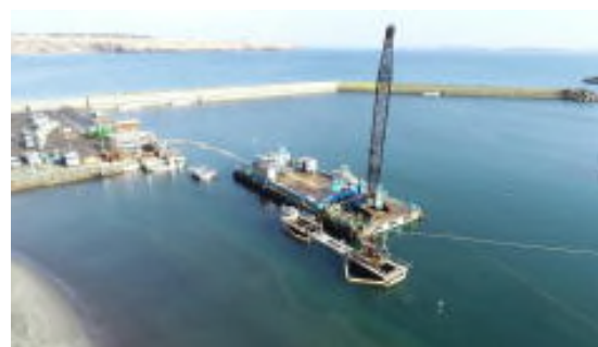
落石地区 係留施設整備状況
