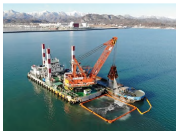
十勝港本港地区 シュンセツ 航路浚渫状況
