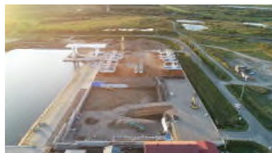
大津地区 漁港施設用地整備状況
