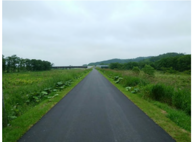
堤防天端保護状況
