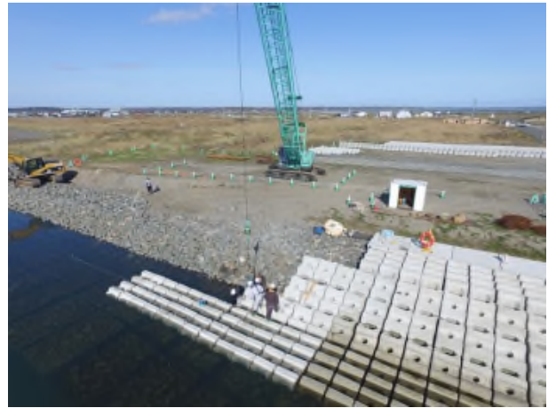
霧多布港本港地区 港湾施設用地護岸整備状況
