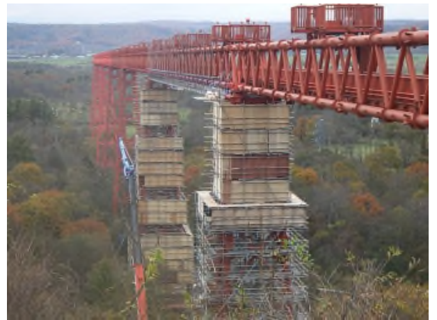
釧路空港 進入灯橋梁改良状況
