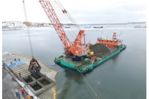
根室港花咲地区 屋根付き岸壁 岸壁部整備状況
