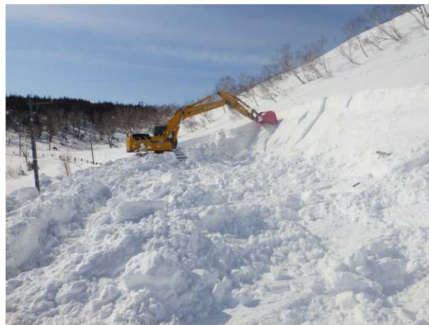
油圧ショベルによる斜面除雪
