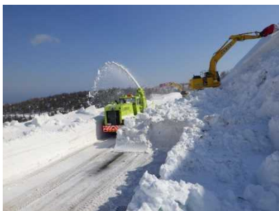
ロータリ除雪車による作業状況
